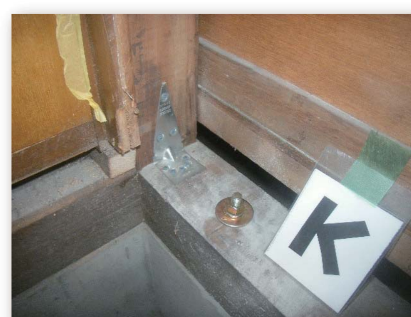
柱脚・柱頭の接合金物取付 (写真は柱脚部)
