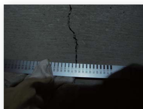
基礎の亀裂確認
