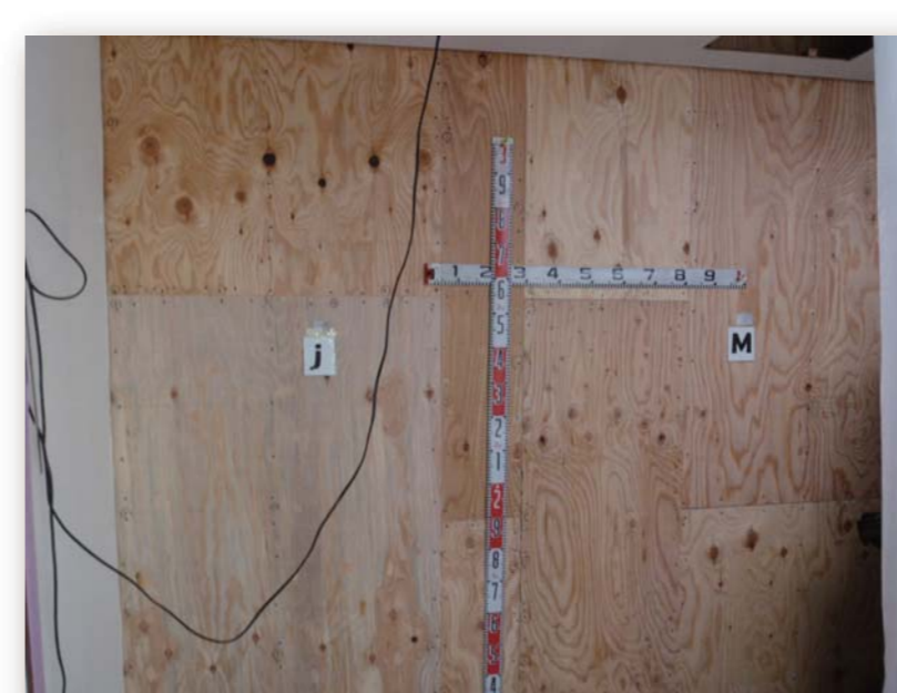
耐力壁の増設 (写真は構造用合板貼り)
