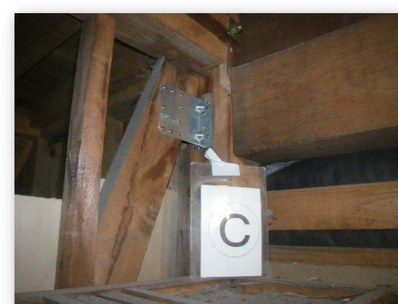
既存筋交いの接合金物取付
