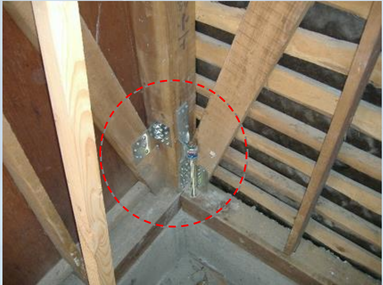
柱脚部ホールダウン金物 筋交金物
