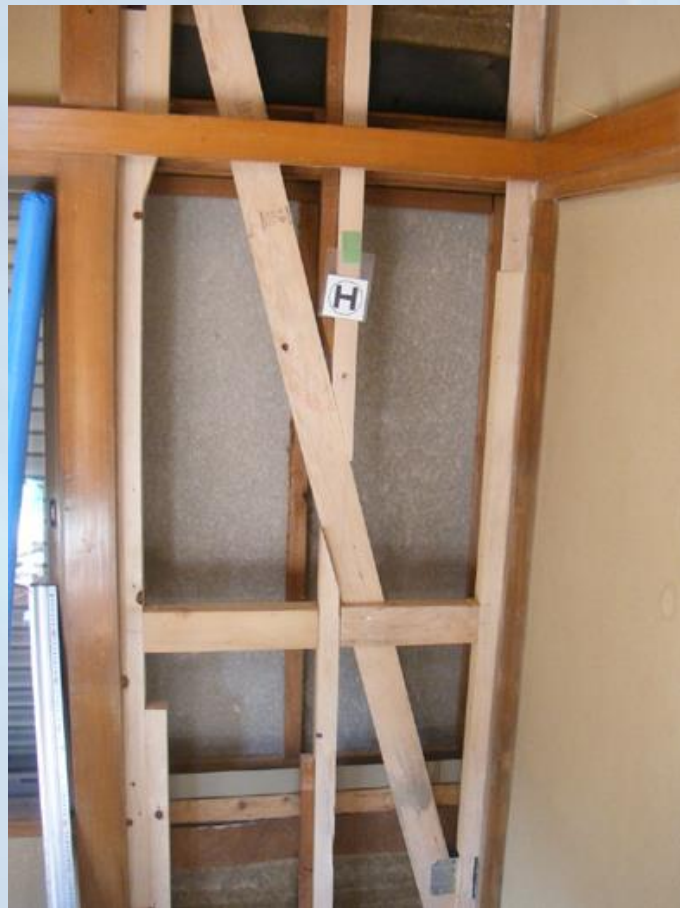
耐力壁下地材設置
