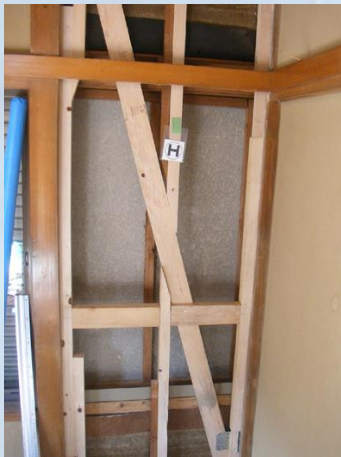
耐力壁下地材設置
